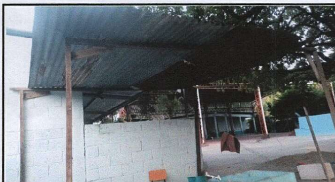
MODULO 3 sustitución de galera de lámina y madera
