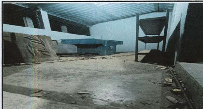
MÓDULO 2: Sustitución de torta de cemento en piso( torta) de área de cocina
